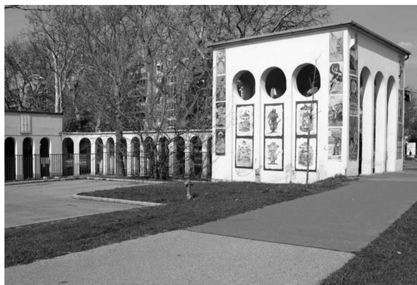
248. Kodály Zoltán Ének-zenei Általános Iskola és Gimnázium (Béke tér 4.). Földszinti árkádcsalád folyosó 249. Strandfürdő (Szabadsághegy utca, Mattyók Aladár ). Árkádcsalád épülete
